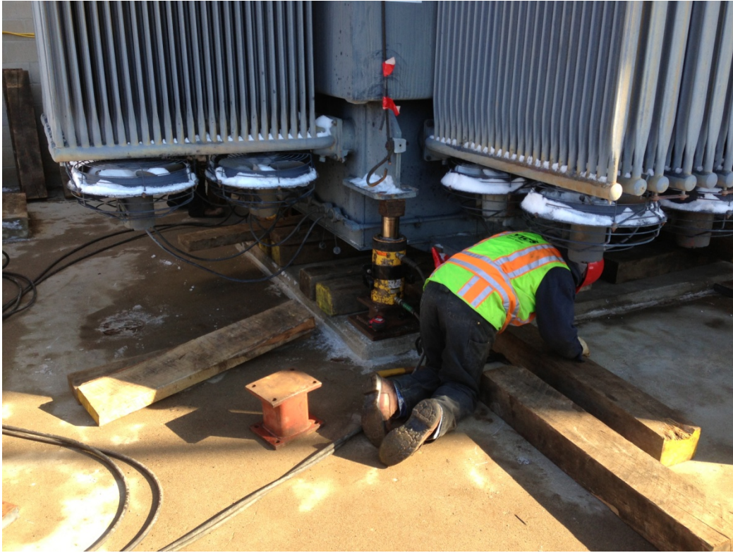
Disconnecting 1R Transformer
