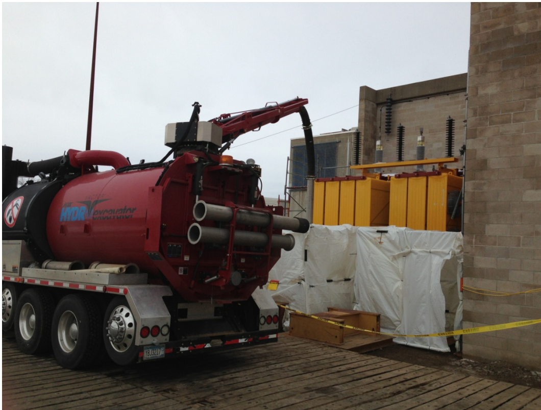
1R Transformer Oil Filling
