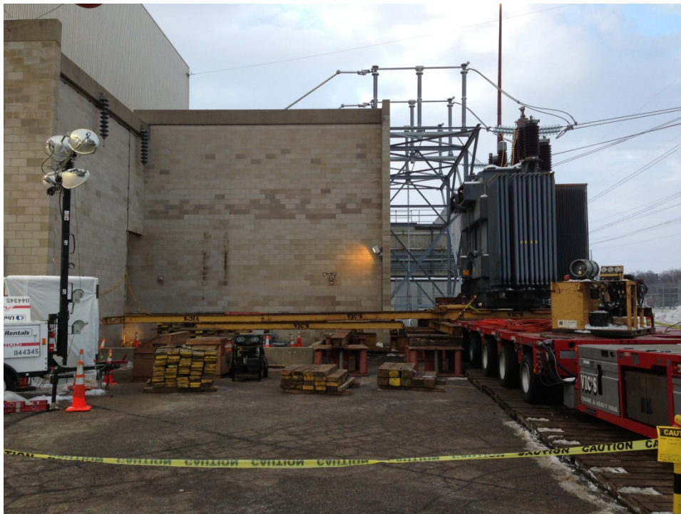
Loading Existing 1R Transformer
