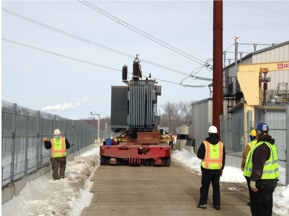
Hauling Existing 1R Transformer
