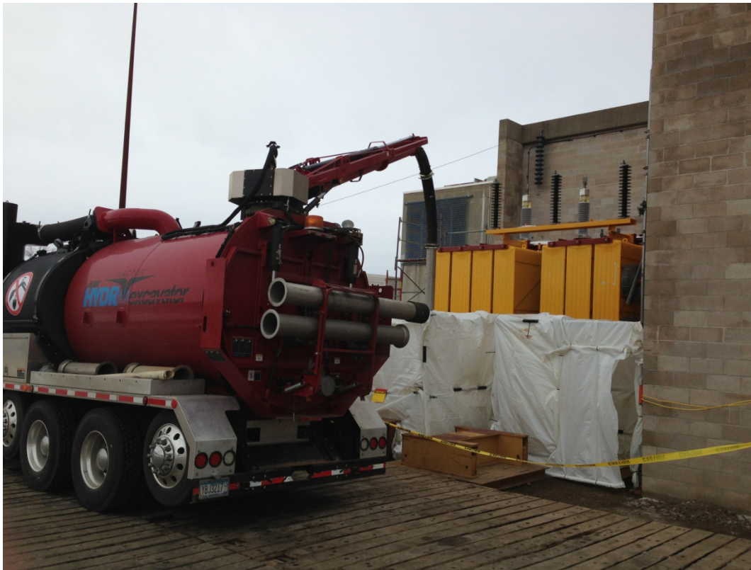
1R Transformer Oil Filling
