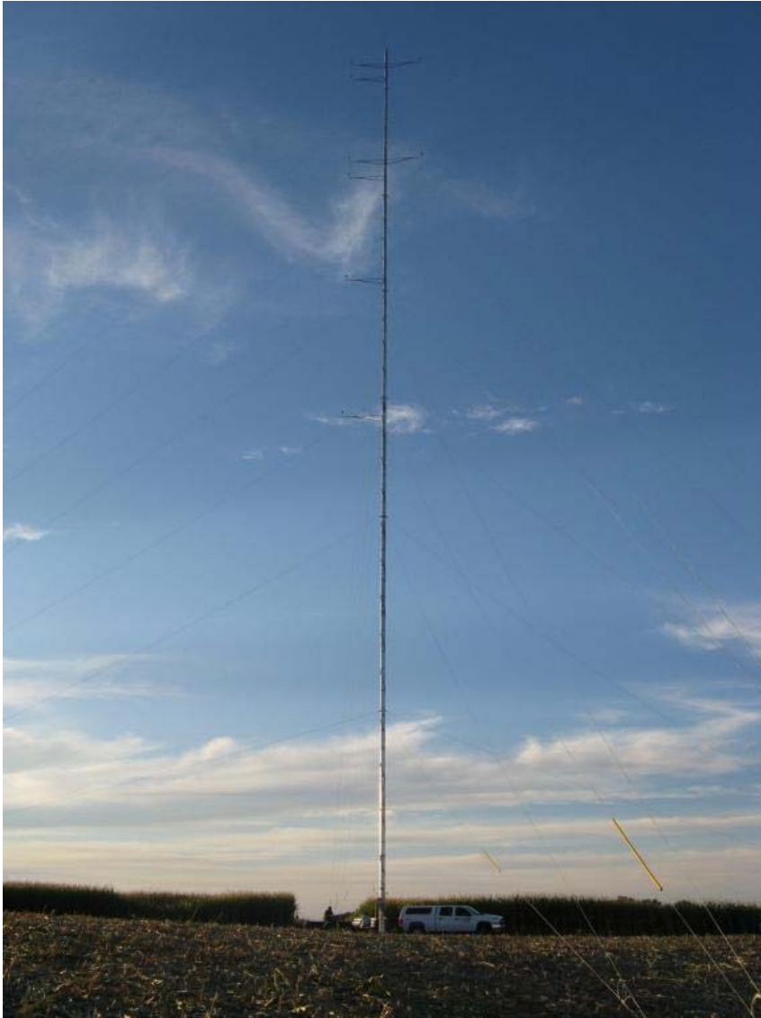
60 Meter Met Tower – Gordon Behm Property
